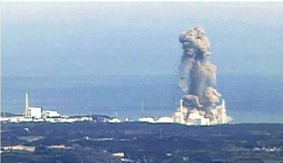
福島第一原子力発電所の1~3号機ともメルトダウンの影響で、水素が大量発生、爆発した。
