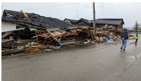
倒壊した家屋
